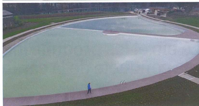
L'EAU DE BAIGNADE EST POMPÉE DANS LE DORLAY
